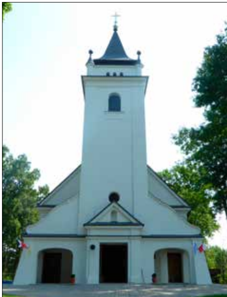
Kościół w Klimówce przed renowacją (z lewej) i w stanie obecnym
