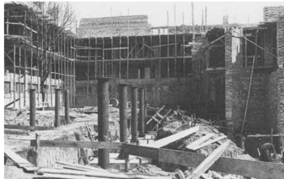
Budowa seminarium – 1982 r.
