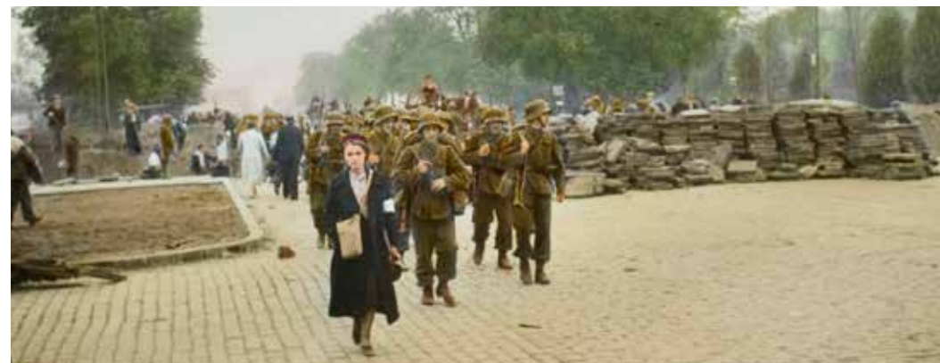
Budowa umocnień na Pradze w rejonie ulicy Zygmuntowskiej (dziś fragment alei Solidarności) i placu Weteranów 1863, 7 września 1939 (AIPN/Kolekcja Juliána Bryana w Warszawie)
