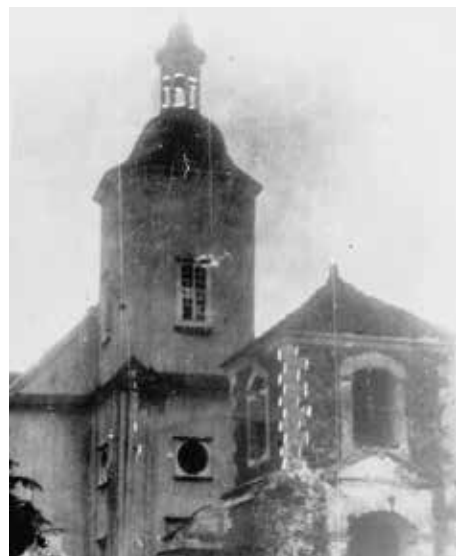
Kościół parafialny z 1779 r. po zniszczeniach wojennych 1914-1918 (fot. Instytut Sztuki PAN w Warszawie)
