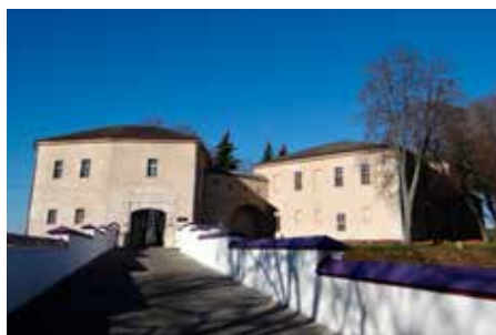
Stary Zamek w Grodnie - stan sprzed rekonstrukcji
