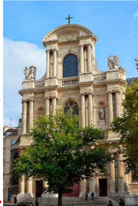
Kościół pw. św. Gerwazego i Protazego w Paryżu
